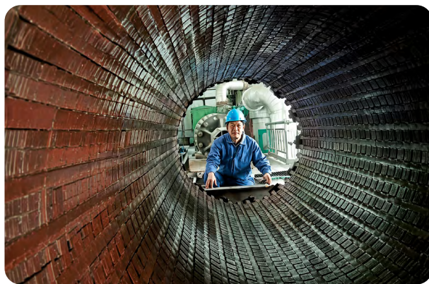
◆ 鹤岗矿业公司热电厂提前检修、守护万家温暖
